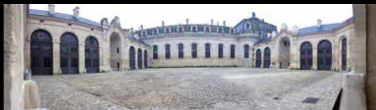
la cour des remises des Grandes Écuries
